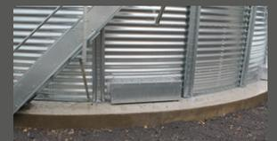
TRAPPE DE NETTOYAGE SOUS PLANCHER
